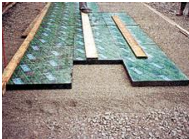
Основание фундаментной плиты – пеностекло FOAMGLAS 480мм
