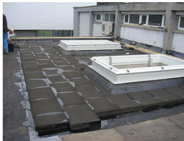
Кровля – пеностекло FOAMGLAS 600мм
