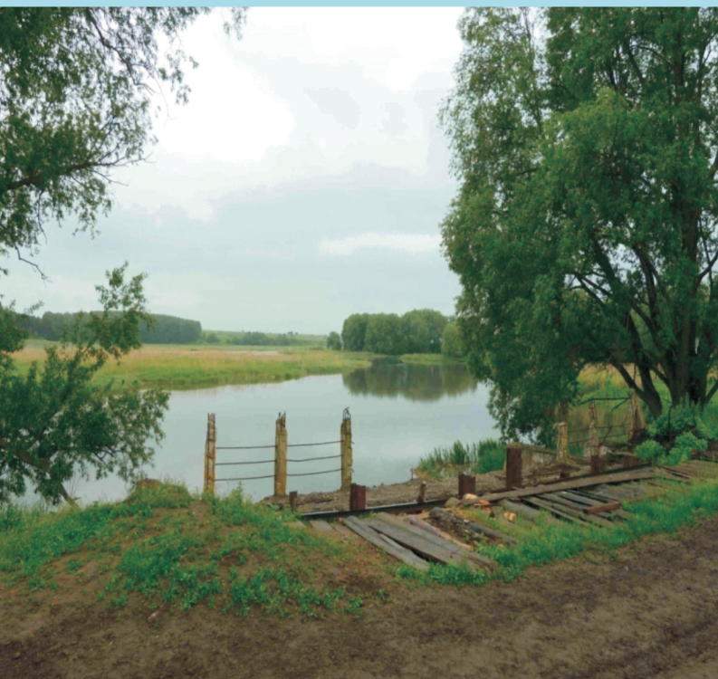
бесхозяйное ГТС пруда п.Советский, вид на верхний бьеф по оси водосброса
