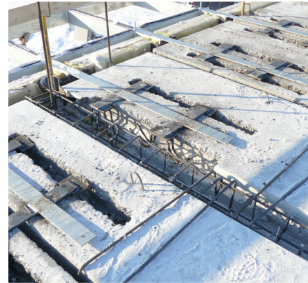
Монтаж балконных плит
