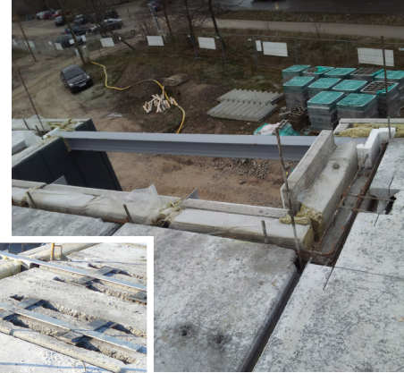
Монтаж балконных плит
